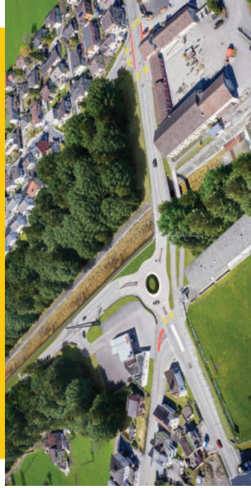
Der Knoten Schächen bei der Chivelli-Kapelle wird im Rahmen des Teilprojekts 2 erneuert.
